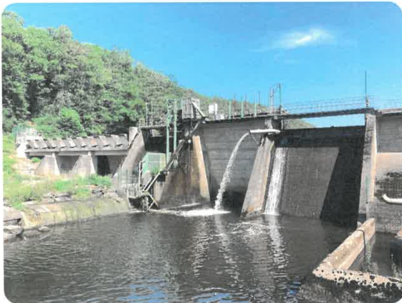
Equipements de franchissement piscicole du barrage de Tréauray : ascenseur à poissons, passe à anguilles et goulotte de dévalaison.
