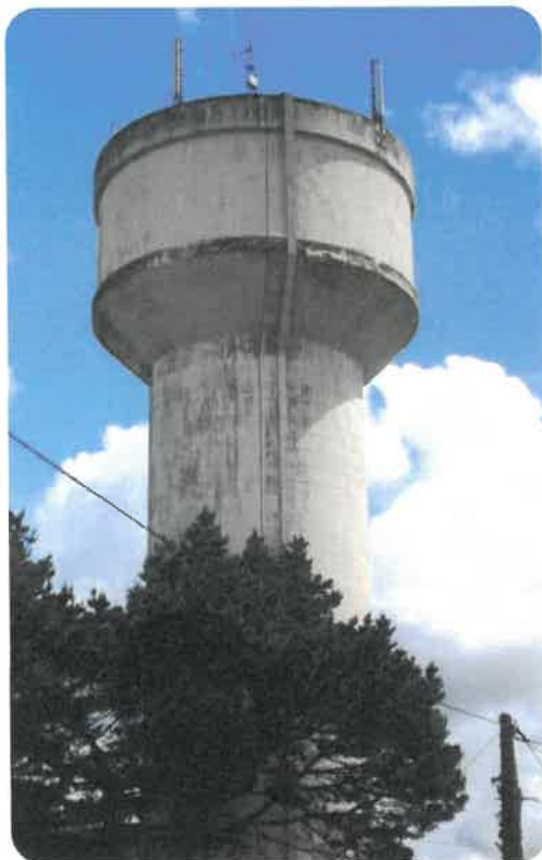
avant les travaux - réservoir de Kerguéro - Brec'h
