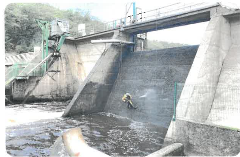
cordistes - barrage de Tréauray
