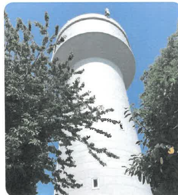
après les travaux - réservoir de Kerguéro - Brec'h
