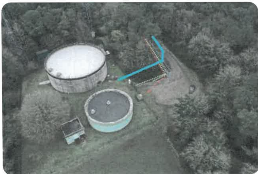
Réservoir de Kerpolican - Baud
