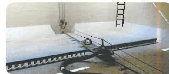
réhabilitation des revêtements - Ploërmel
