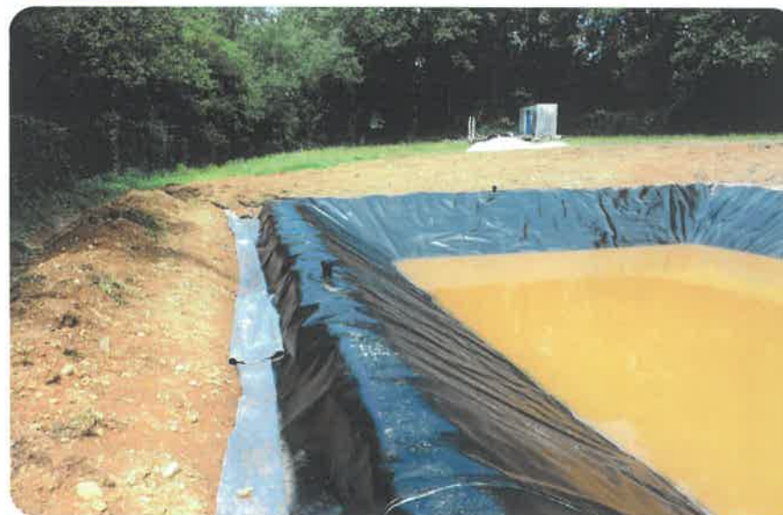
unité de production des Moulins - Rieux
