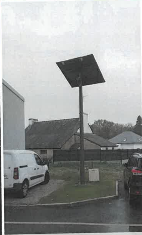
À Colpo, un panneau solaire alimentant cinq luminaires, une technique souple et sobre d'extension de l'éclairage public, financée à 50 % par Morbihan Énergies.
